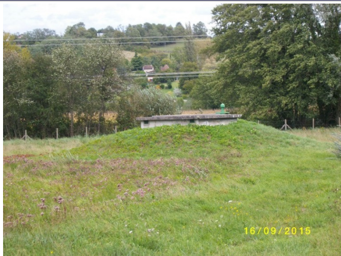
Captage des Teppes (crédit photo : La Drôme Laboratoires)
