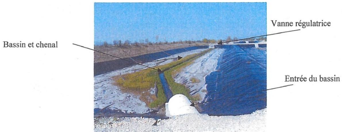
Figure 15 : Bassin de décantation des eaux pluviales de Brezins
